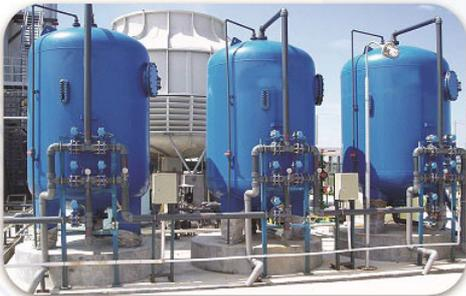
دستگاه فیلتر شنی تشکیل یافته از ورق فولادی  $st37$  با سه لایه رنگ اپوکسی می باشد. این دستگاه شامل نانو متر، شیر هوادهی، دریچه بازدید بستر سیلیسی می باشد. در تصفیه آب به این روش ذرات معلق آب در فضای حاصل از خلل و فرج بستر سیلیسی محبوس می شوند و در نتیجه ذرات معلق حذف می گردند.
